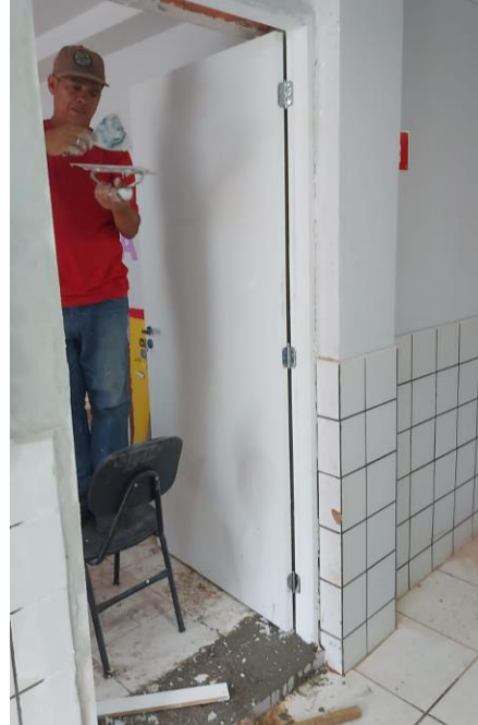
Substituição de maçanetas e abertura de uma porta nova
