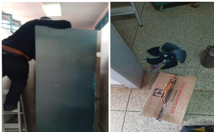
manutenção da camara fria
