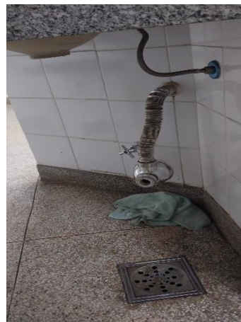
troca do sifão da pia
