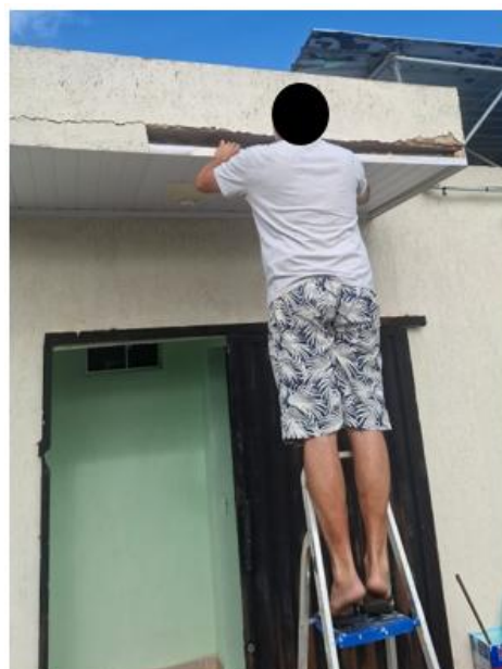
Conserto de rachadura
