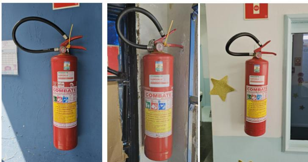
Troca dos extintores
