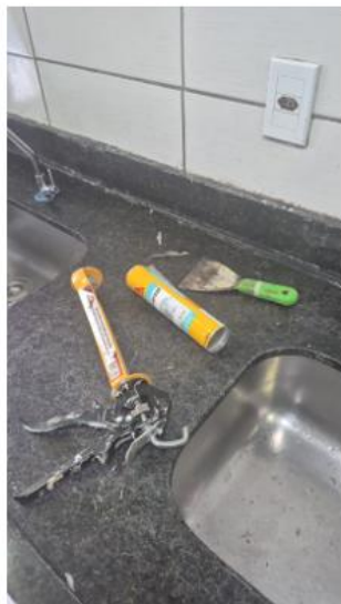
Aplicação de silicone nas pias da cozinha
