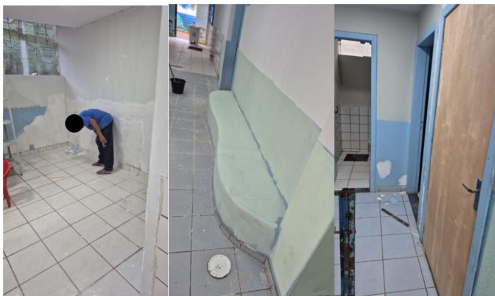
Pintura na parte interna da instituição
