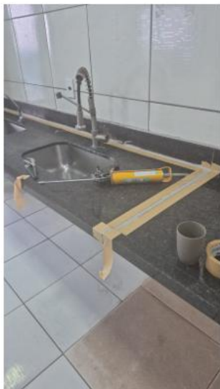
Aplicação de silicone nas pias da cozinha
