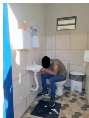
troca das torneiras dos banheiros funcionários
