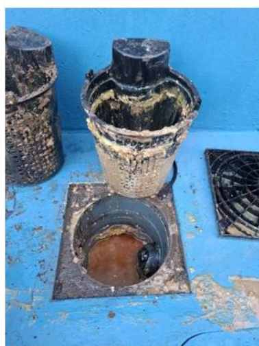
limpeza e troca da caixa de gordura
