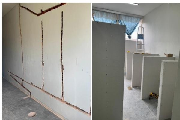
construção do novo banheiro
