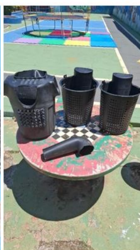
limpeza e troca da caixa de gordura
