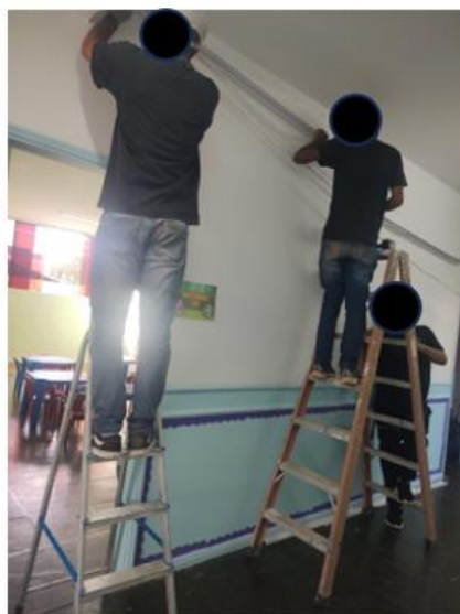
Instalação de canaletas
