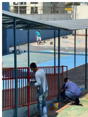
pintura nas dependências da instituição
