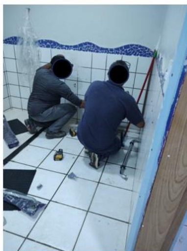
Instalação das barras de apoio
