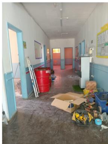
Pintura do corredor
