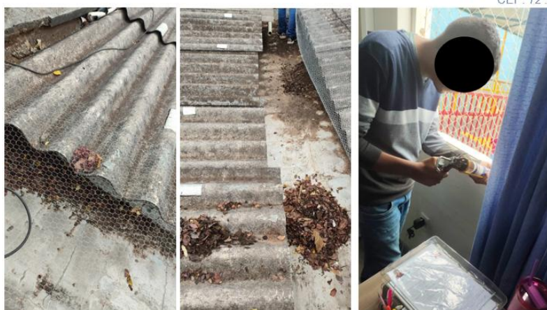
Limpeza das calhas do telhado
