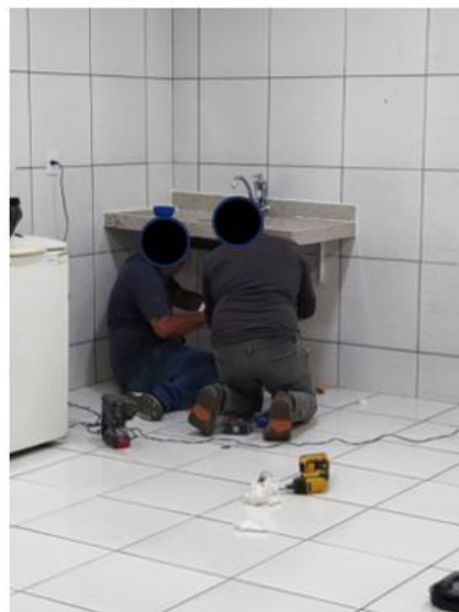
Instalação da bancada na cozinha
