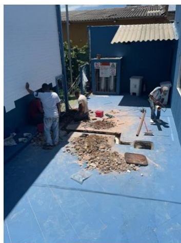
manutenção nos canos de esgoto
