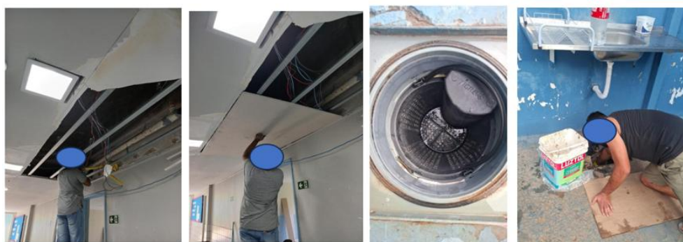
Substituição de forro do teto
