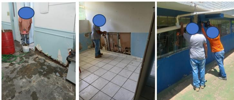
Conserto de vazamento de cano de água
