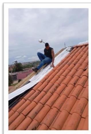
Trocas de telhas quebradas, instalação de manta asfáltica em pontos necessários dos telhados.
