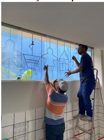
troca do vidro da janela
