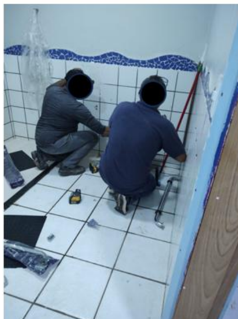
Instalação das barras de apoio
