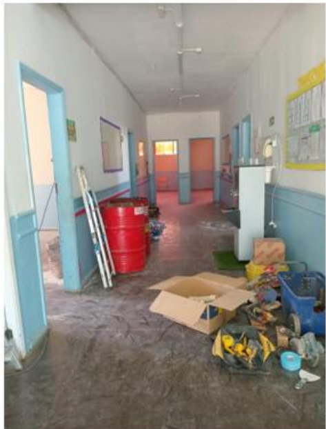
Pintura do corredor
