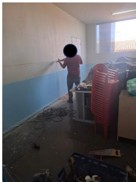
Instalação de tomadas
