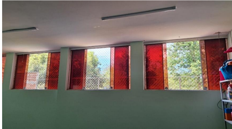
Instalação de redes de proteção
