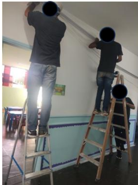
Instalação de canaletas
