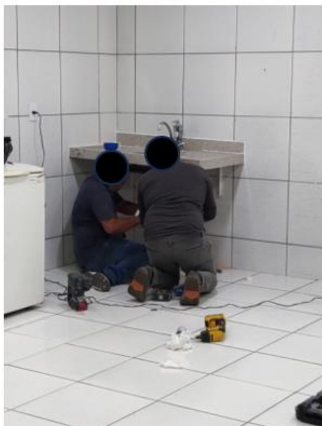
Instalação da bancada na cozinha
