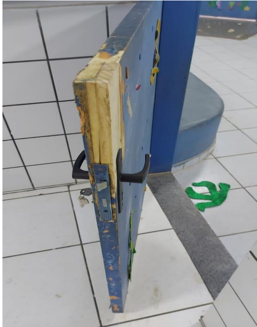
Substituição de maçanetas e abertura de uma porta nova
