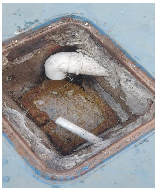
Limpeza da caixa de gordura
