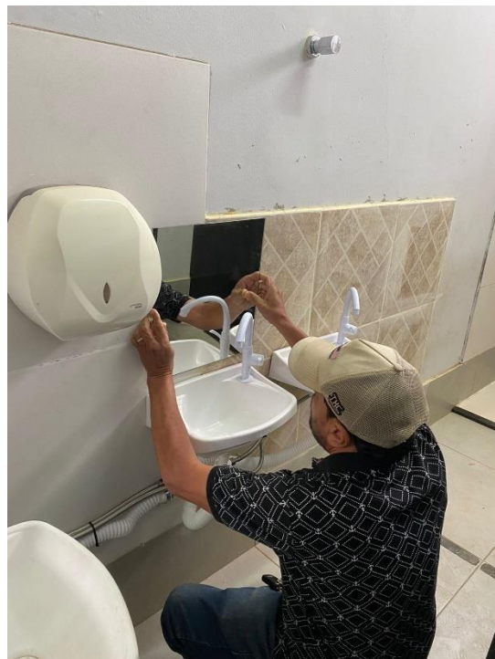
Instalação de espelhos e troca das torneiras
