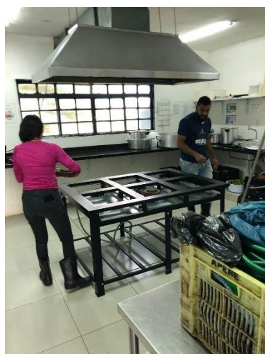
Manutenção do fogão
