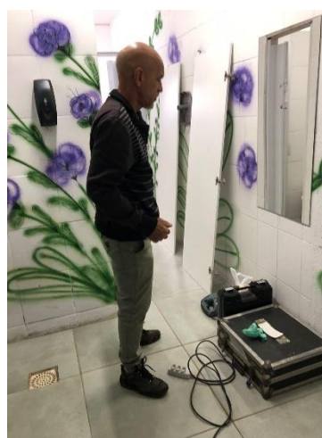
Instalação portas- banheiros
