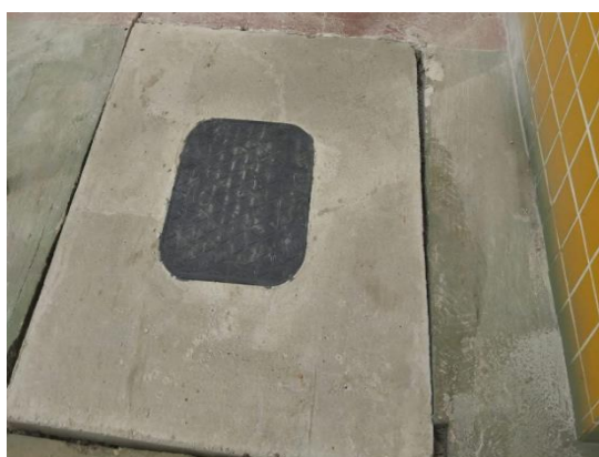
Troca das tampa dos esgotos que estavam quebradas.
