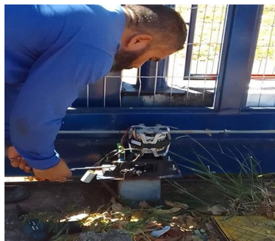
Manutenção do motor do portão.
