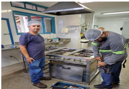
Manutenção do fogão
