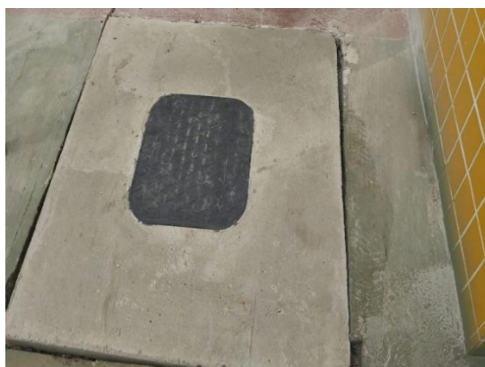
Troca das tampa dos esgotos que estavam quebradas.
