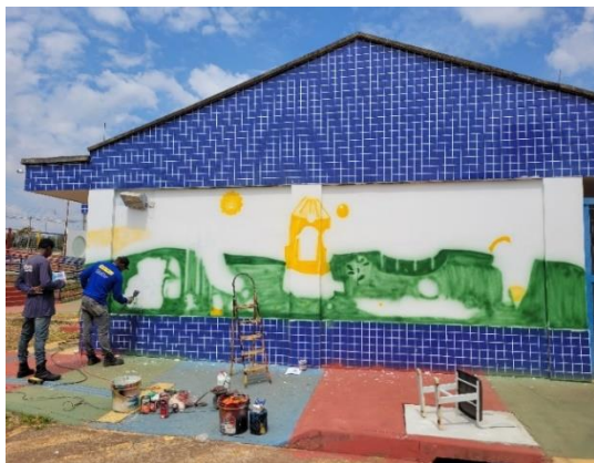
Pintura de revitalização da fachada da creche.
