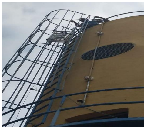
Limpeza da caixa de água
